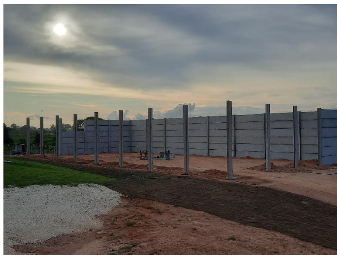
Figura 7 – Pilares estrutura pré-moldada
